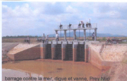
barrage contre la mer, digue et vanne, Prey Nup
